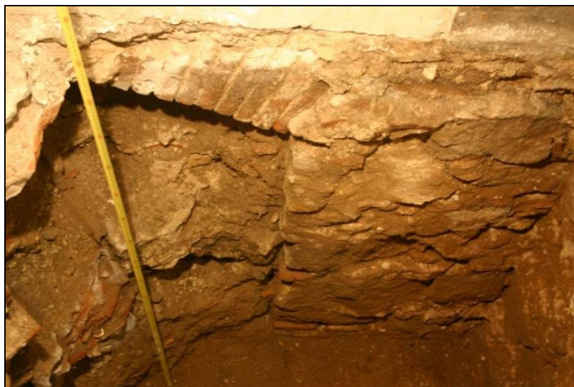
Figura 4. Detall de l'arc de descàrrega a UE.102.
